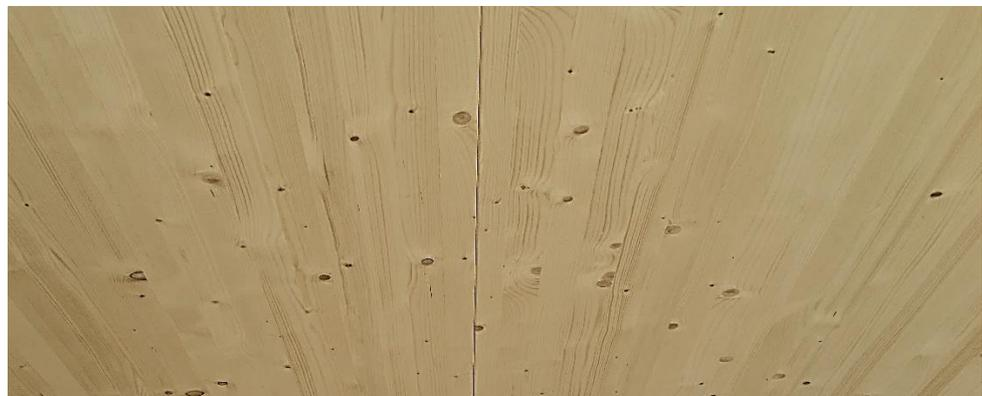
Grundsätzlich darf die **NURHOLZ BRST Sicht** Oberfläche nicht mit einer Schalung O/1er Hobelqualität bzw. Schreinerplatten, etc. verwechselt werden. Dies allein schon deshalb, weil die Decklagen gehobelt sind und nicht 100%-ig fugenfrei gefertigt werden.
